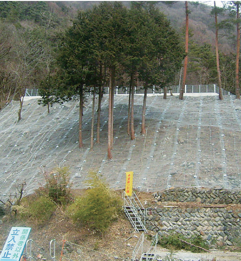
หลังติดตั้งเสร็จ
