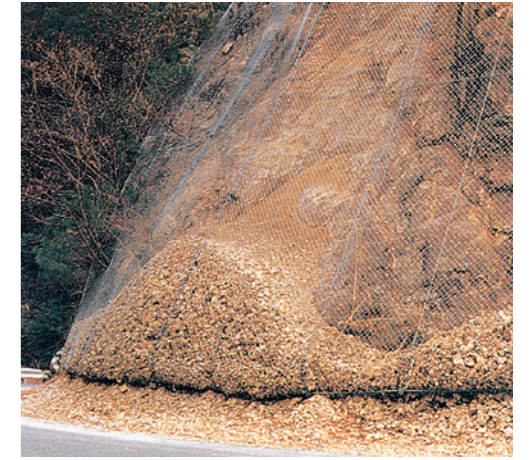
การติดตั้งตาข่ายทั่วไป
