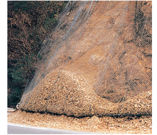
Thi công lưới thông thường
