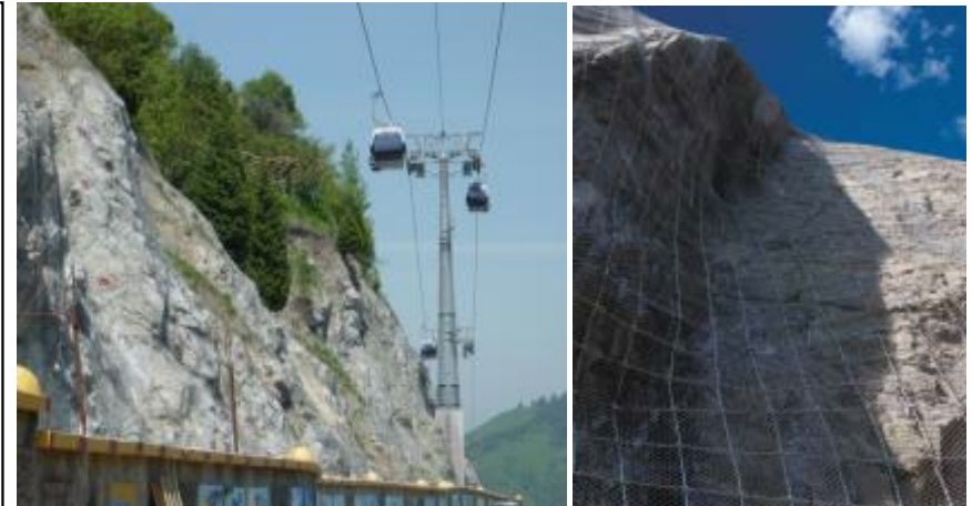
カザフスタンメデウ地区落石対策実績
