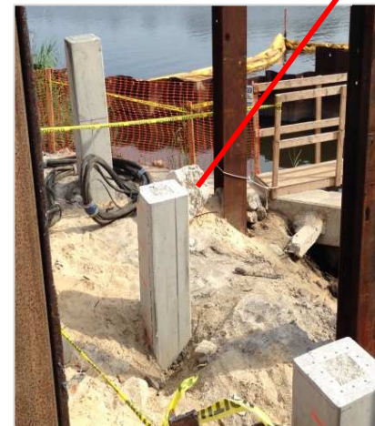
コンクリート杭 内部のCFCC
