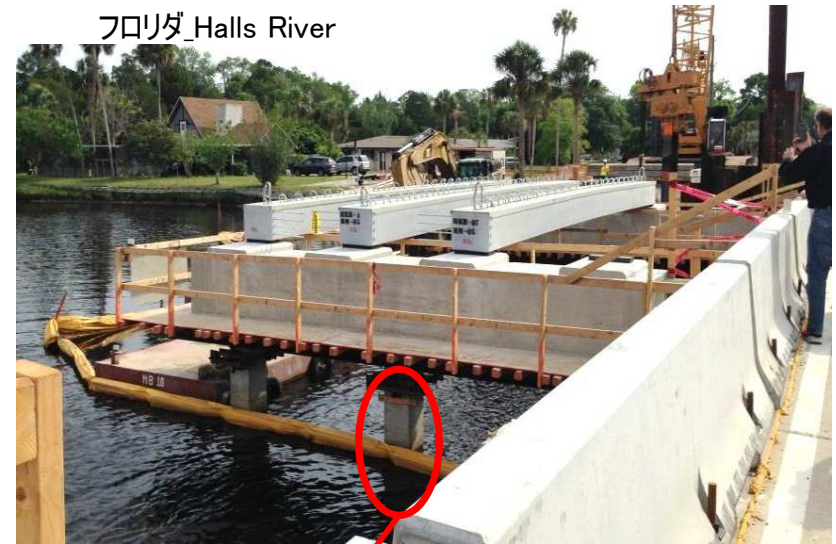
コンクリート杭 内部のCFCC
