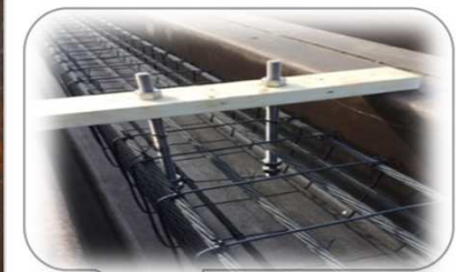
コンクリート杭 内部のCFCC
