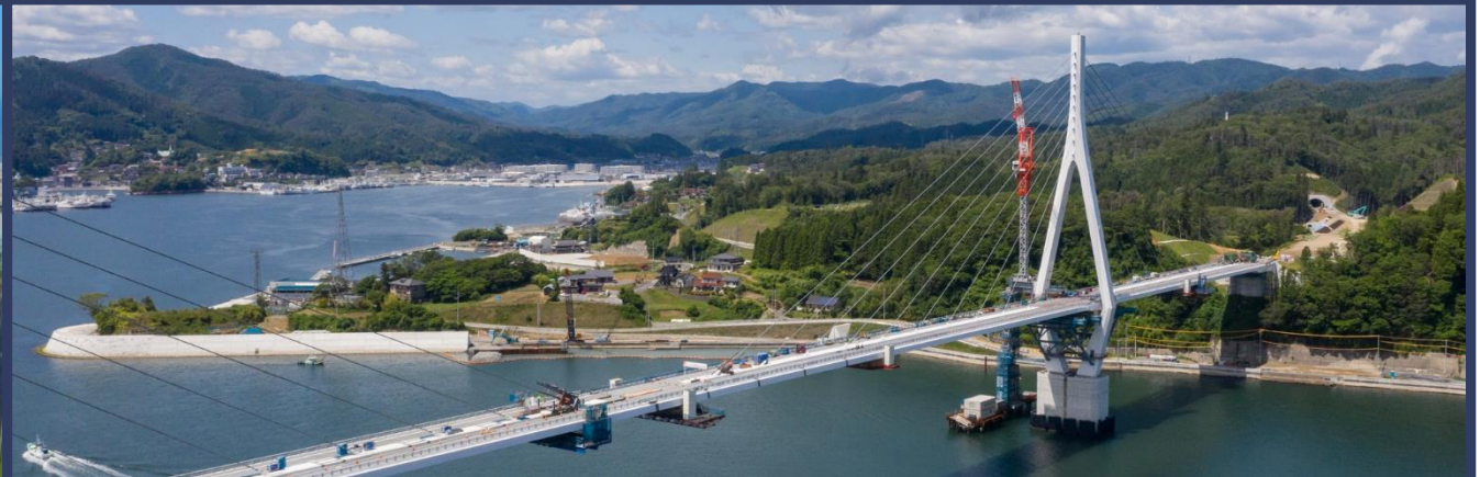
橋梁ケーブル
