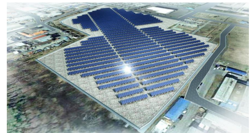
写真) 東京製綱八戸太陽光発電所
