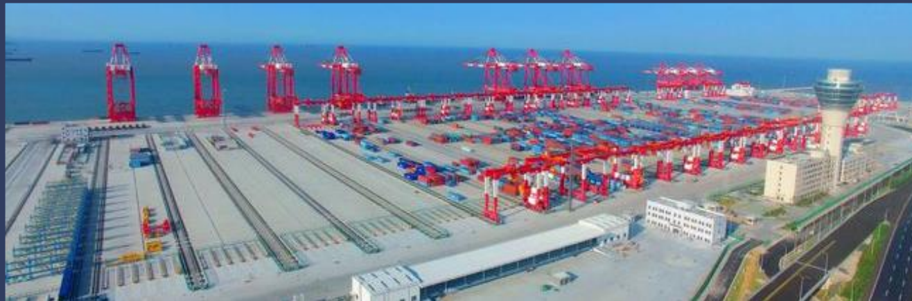
自動化ポート用クレーンロープ
