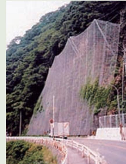
カーテンネットは、支柱やロープが落石の直撃を受けやすい、沢部や崖すい域等の不安定な箇所には設置できないといった従来の落石防護工の問題点を解消するとともに、落石のエネルギー吸収を飛躍的に高めた高エネルギー吸収落石防護工です。
