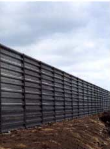
防風柵架設状況
