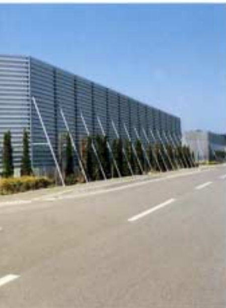
特殊型砂防柵の架設状況
