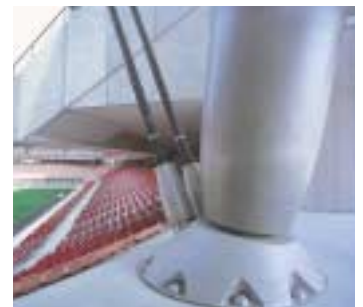
ケーブル端部
