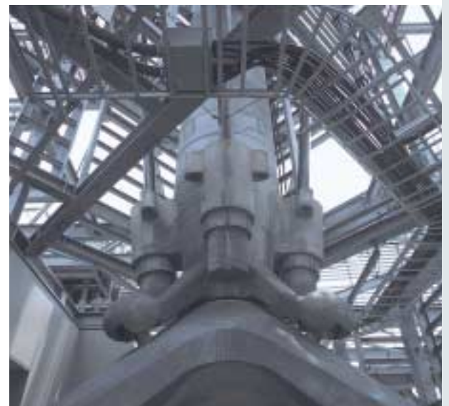
ピボット支承部
