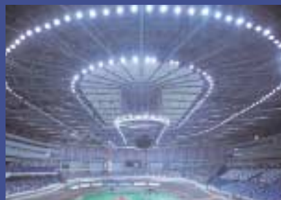
グリーンドーム前橋
