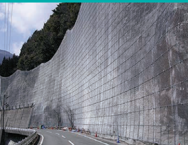
カーテンネット工法
