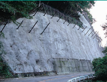
ロックネット工法
