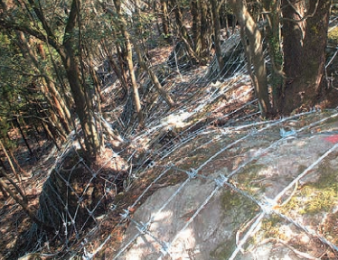
ロープネット工法
