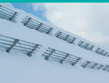
吊柵(雪崩予防工)
