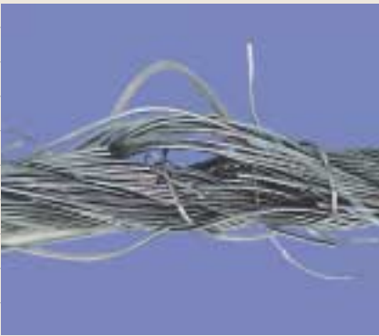
断線により発生した切断事故後の状況。
