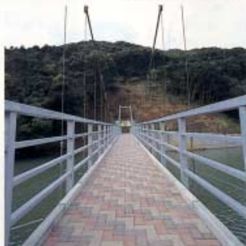
長崎県諫早市◎観水公園吊橋
