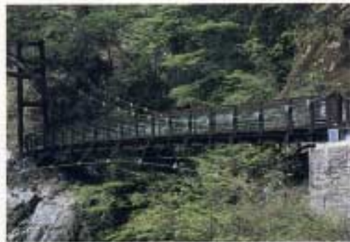
奈良県天川村◎ミタライ鉄吊橋
