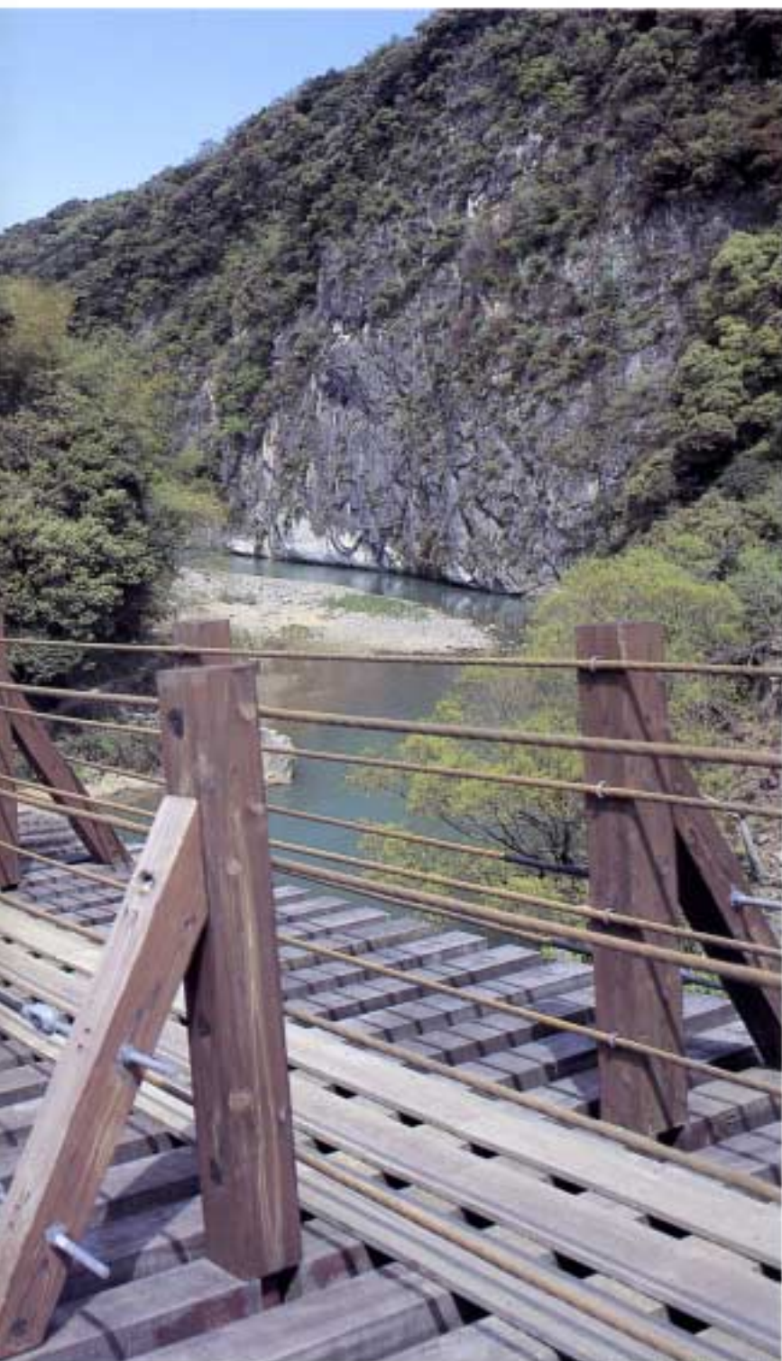
熊本県宮原町◎尾神橋
