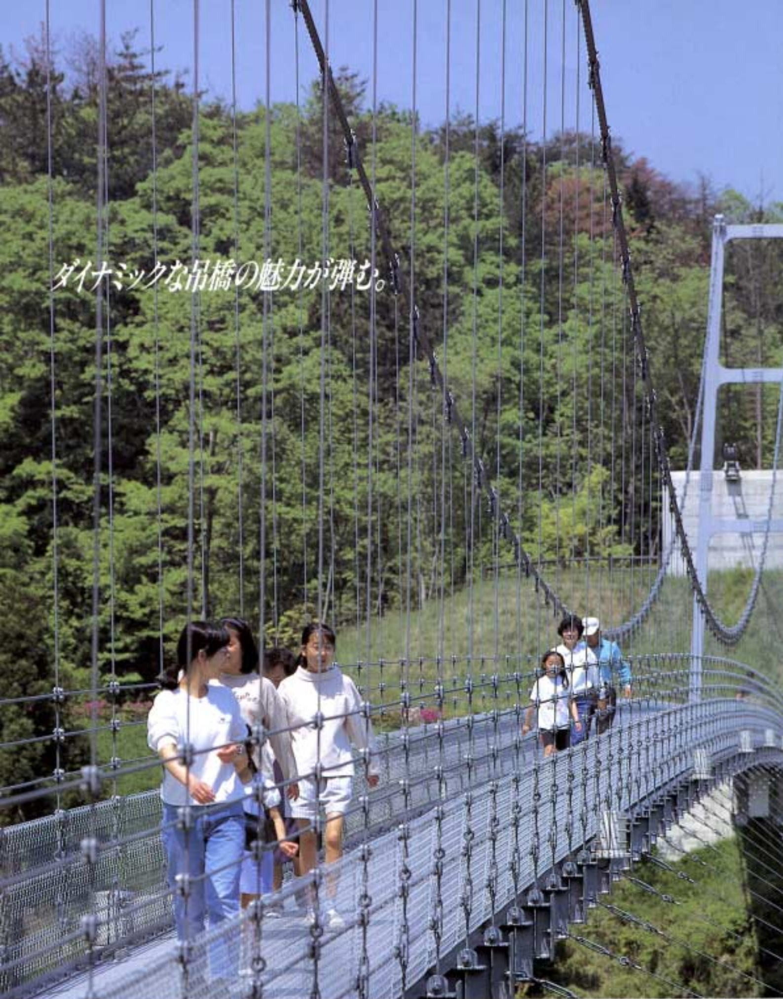
三重県伊賀上野市◎しあん橋
