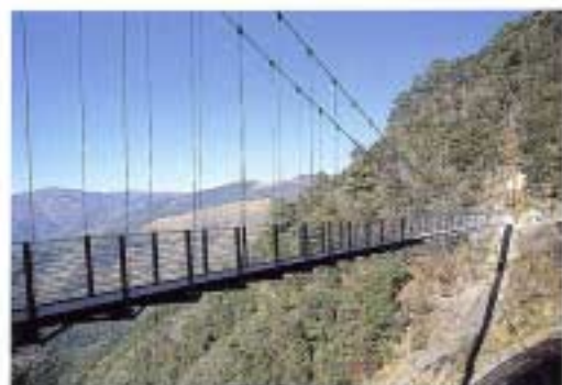
熊本県水上村●白龍王橋
