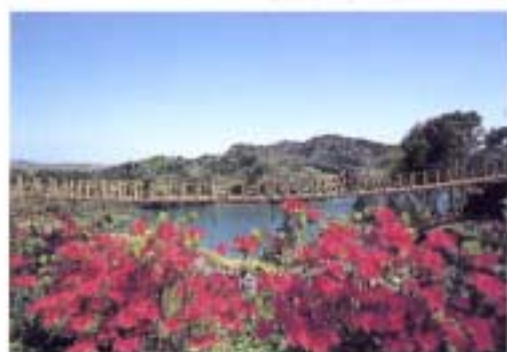
長崎県琴海町◎中央公園吊橋
