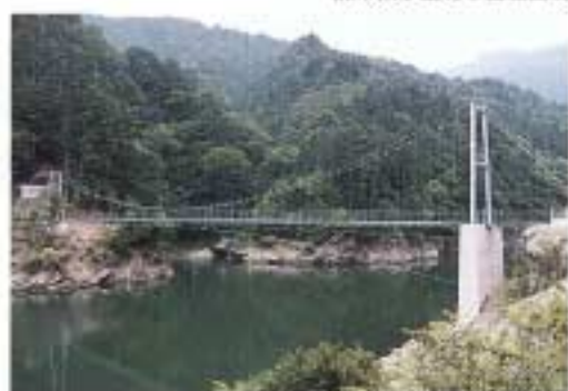
高知県本川村●木の根三里橋
