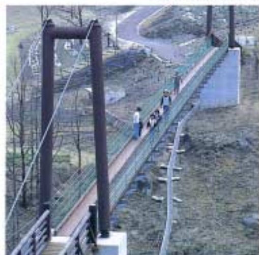
大分県 県民の森◎香りの森広場吊橋
