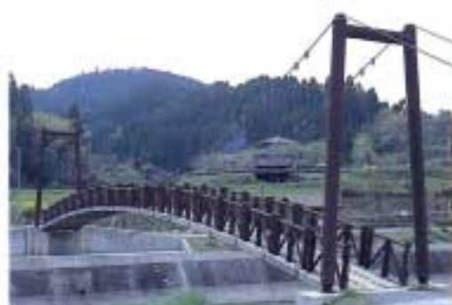
熊本県鹿北町 岩野川畔公園◎水天宮吊橋
