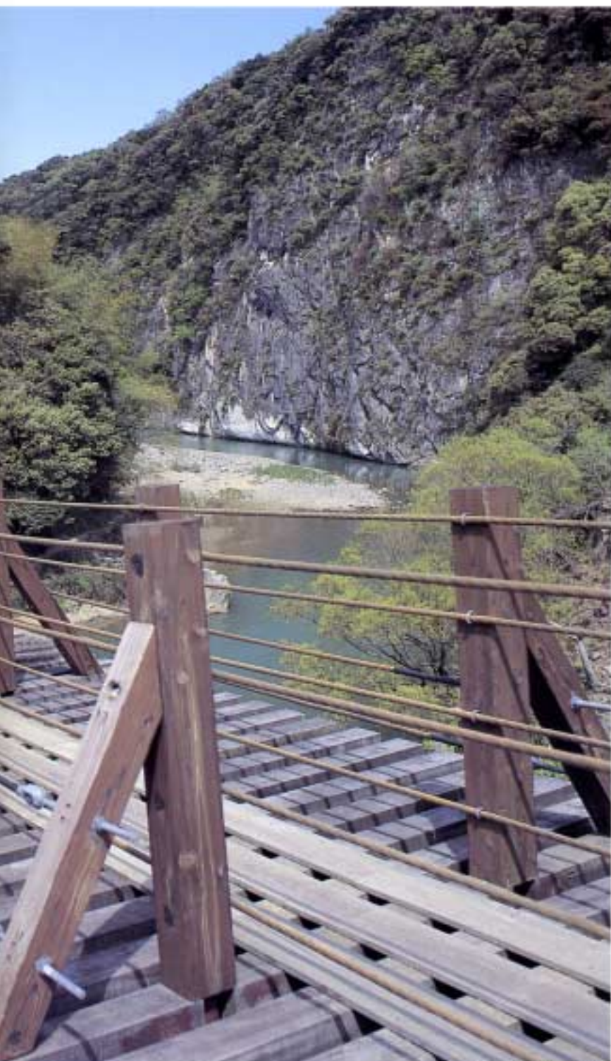
熊本県宮原町◎尾神橋
