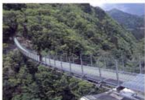
徳島県東祖谷村◎龍宮橋
