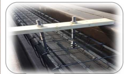
コンクリート杭 内部のCFCC
