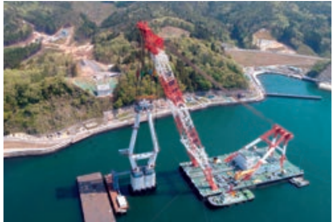
架設状況(2019年5月) 提供:国土交通省 東北地方整備局 仙台河川国道事務所
