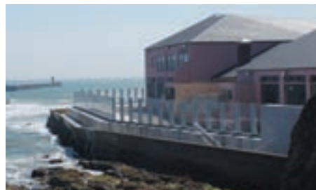
アクリル止水パネル (福島県いわき市)
