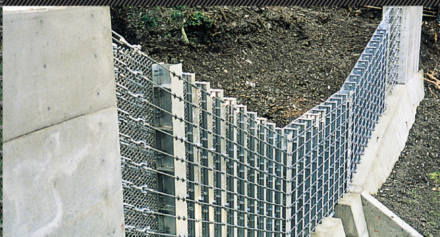
FMF-DC20NC300-0.5型(端末部:コンクリート製) 沢部に設置
