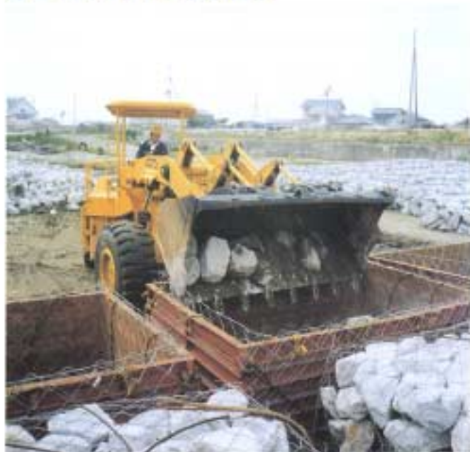
④ロックマットに石材投入
