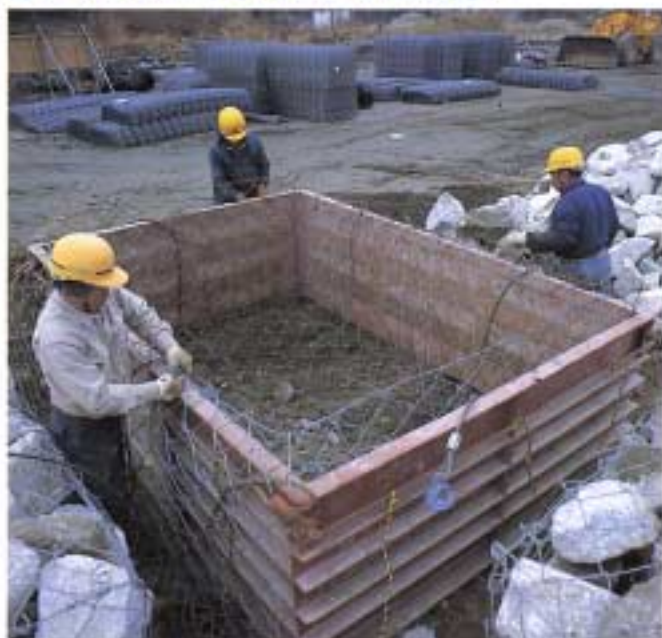
③ピットにロックマットをはめ込む
