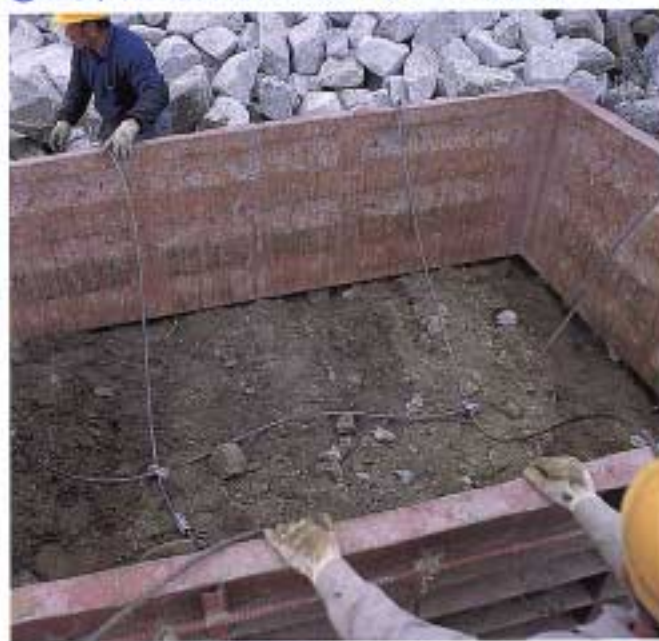
② ピットにスリング・バランスロープを敷き込む
