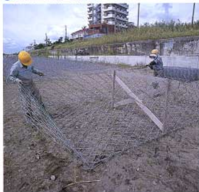
① ロックマットの仮組み
