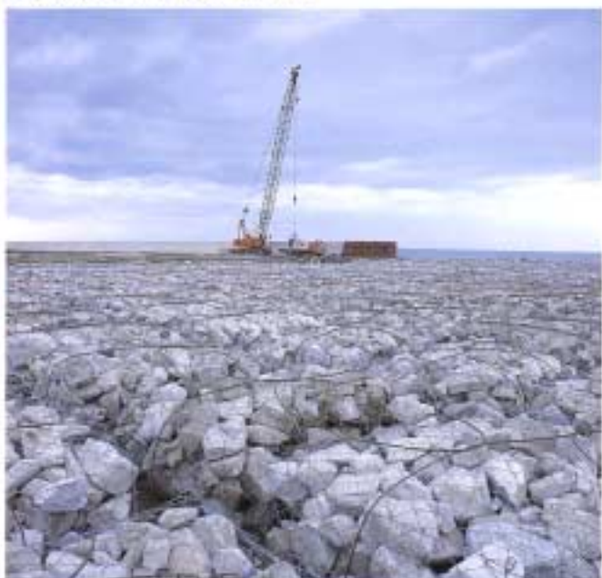
⑦完成したロックマット
